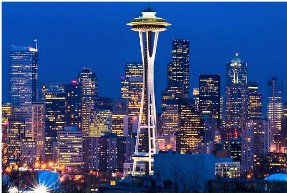
Figure 14 – Construite pour l'Expo de 1962, la Space Needle est l'emblème de Seattle
