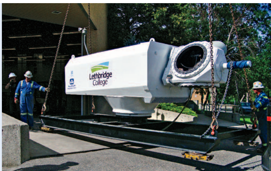
Des ouvriers assemblent l'éolienne au Collège Lethbridge.
